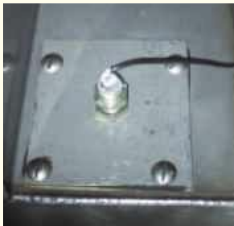
Trappe de visite de la cuve et sécurité manque d'eau
